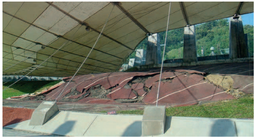
Abb. 2 Verwerfung auf dem Sportgelände der ehemaligen Guangfu Junior High School in Wufeng (Taiwan). Die etwa 2 m hohe Steilstufe – hier schräg zur 400-Meter-Laufbahn verlaufend – entstand bei dem Jiji-Erdbeben am 21. September 1999 (Magnitude M 7,6 ). Foto: Ivo202 (Wikimedia Commons), 921 Earthquake Museum of Taiwan.
