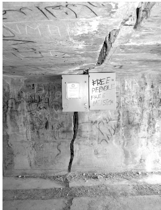
**Abb. Z-5 (links) und Z-6 (rechts):** Verlassener, ehemaliger militärischer Stützpunkt mit Erdbebenschäden in moderner Stahlbeton-Architektur. Die Lokalität befindet sich auf den Golanhöhen SO des See Genezareth, etwa 8 km OSO Kinneret. Das Datum des Erdbebens ist dem Verfasser nicht bekannt. Foto: M. KOTULLA, 2007.
